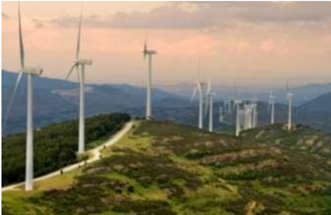
Parque Eólico de Yerga
